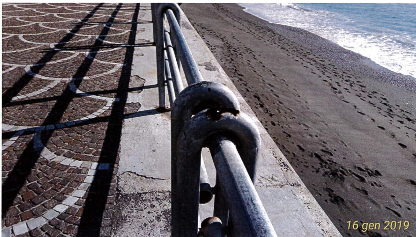
FOTO 2. VISTA PARTICOLARE RINGHIERA DA SOSTITUIRE
